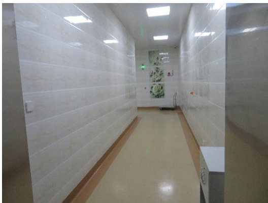
图 3-1 直加机房迷道
