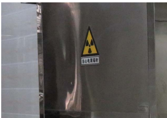
图 3-9 直加机房防护门上警示标识
