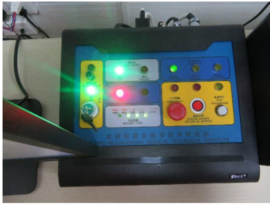
图 3-9 控制室内声光报警装置
