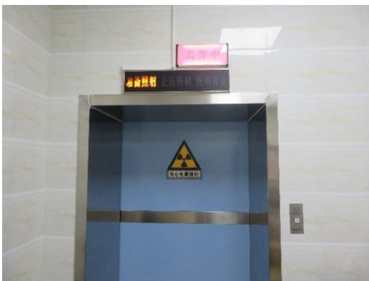
图 3-2 机房防护门及工作指示灯
