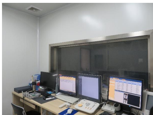
图 3-1 控制室铅玻璃观察窗
