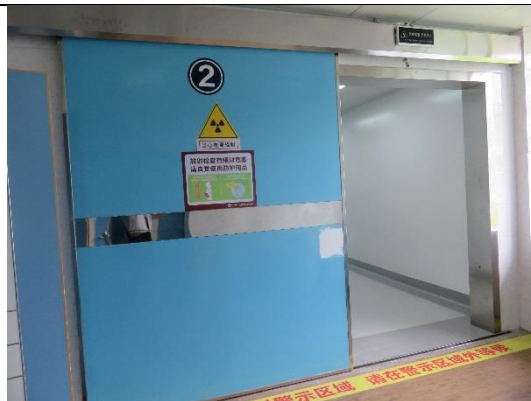
图 3-4 病人出入机房防护门
