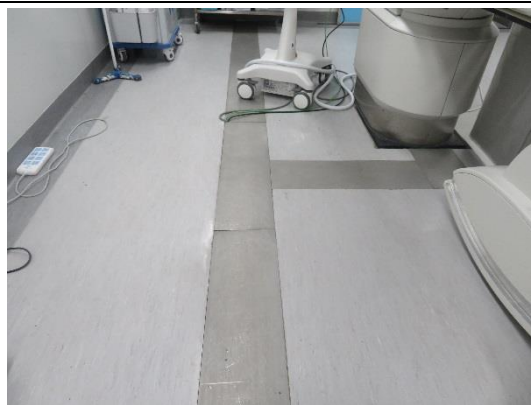
图 3-12 机房内线槽
