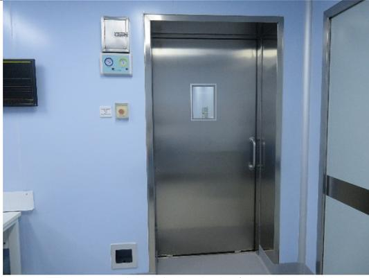
图 3-3 控制室出入机房防护门
