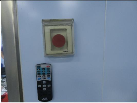
图 3-11 机房内紧急停机开关
