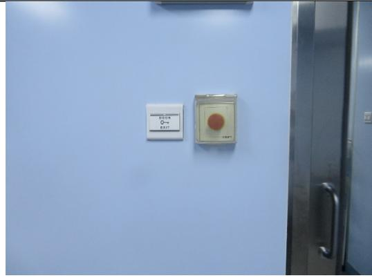
图 3-12 机房外紧急停机开关
