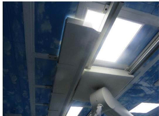
图 3-10 机房顶棚走线
